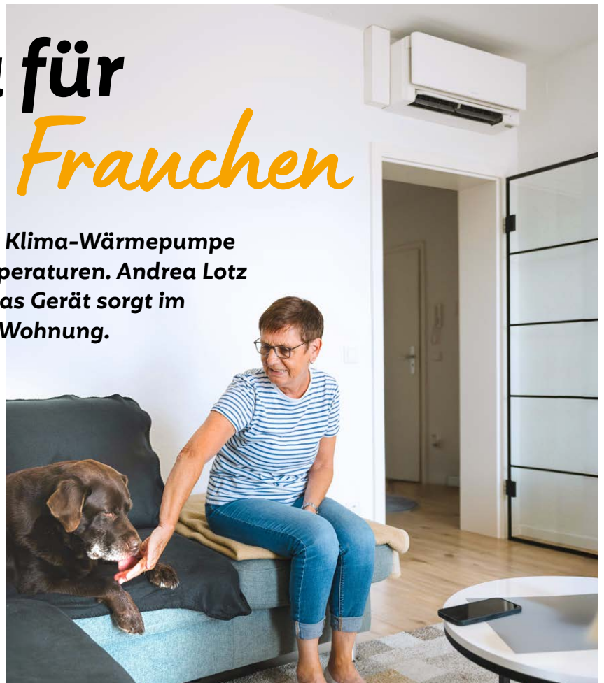
Da fühlen Mensch und Tier sich wohl: Aus den Wandgeräten strömt je nach Bedarf kühle oder warme Luft in die Wohnung von Andrea Lotz.
